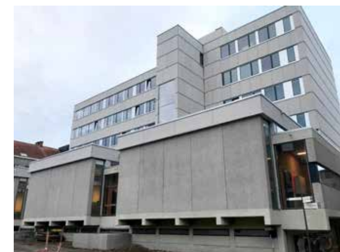
De volledige dakopbouw van de lage daken is gedemonteerd en vervolgens van een dampscherm en isolatie voorzien en waterdicht gemaakt.
