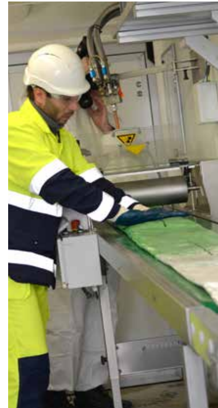
Een van de meest gehanteerde technieken voor een sleufloze rioolrenovatie is een relining met TPUB.
