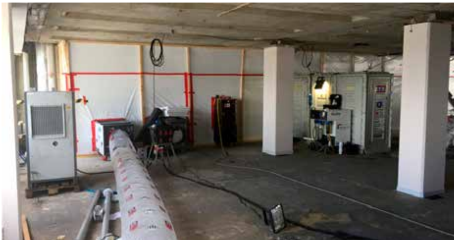
Een buitenzicht van een saneringszone, opgebouwd door Renotec-arbeiders. Links staat het afzuigstelsel dat voor de onderdruk zorgt. De ruimte zelf is luchtdicht gemaakt.
