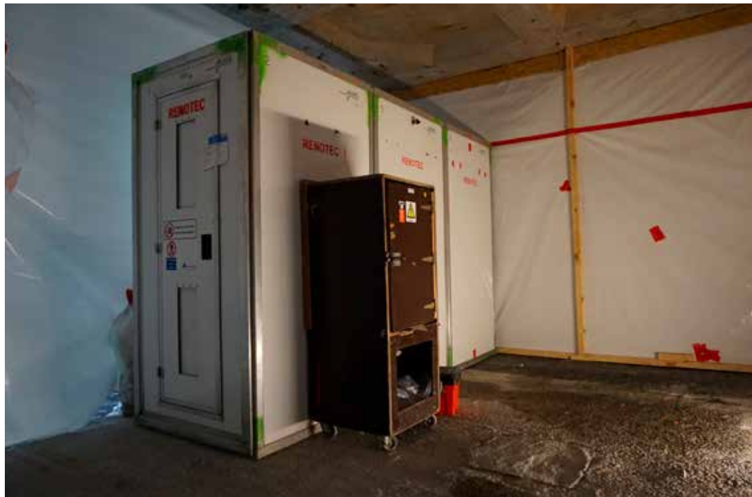
Deze saneringszone is luchtdicht gemaakt met plastic folie. Een drietrapssluis met een 'schone ruimte', een douche, een 'vuile ruimte' en een houten materiaalsluis laat arbeiders toe om de ruimte veilig te betreden en te verlaten. Regelmatig wordt de lucht binnen en buiten de installatie gemeten.
