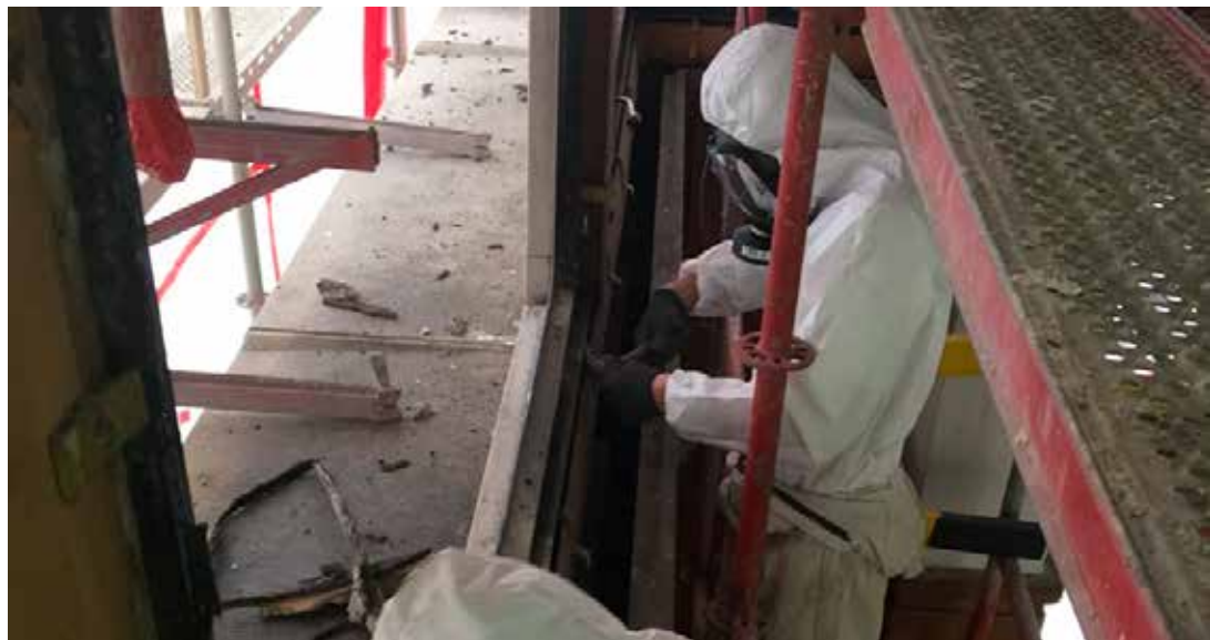
Asbestsaneerders aan het werk.
