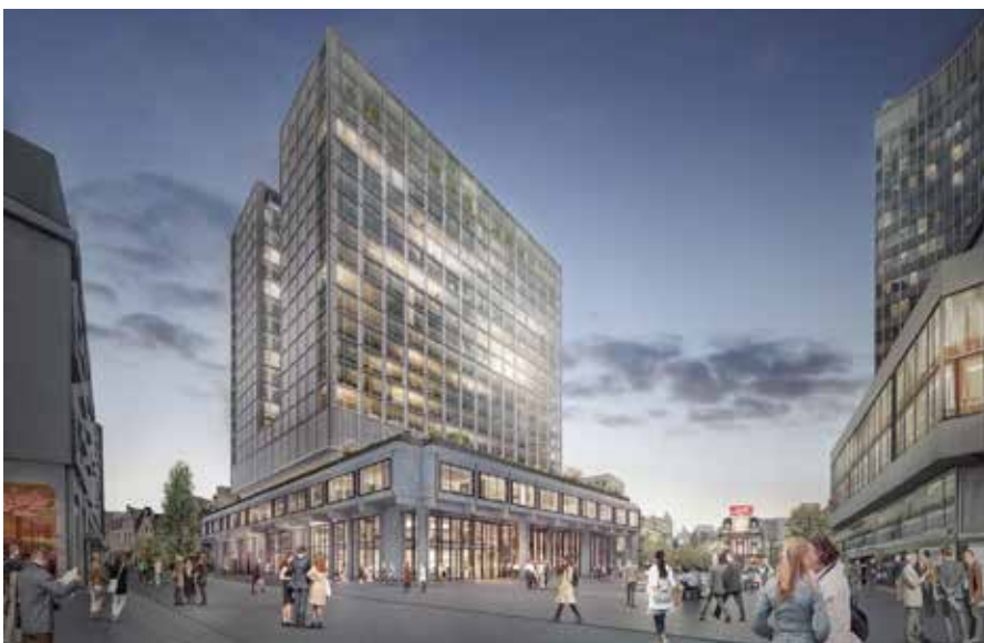
Het De Brouckèregebouw krijgt deze dagen een grondige make-over. (Beeld: Whitewood/Conix RDBM).
