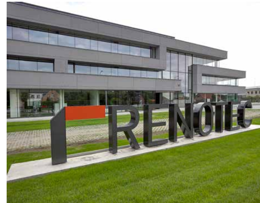
Het BEN-kantoorgebouw in Geel is de nieuwe uitvalsbasis van Group Renotec. (Beeld: Dominique Van Huffel)
